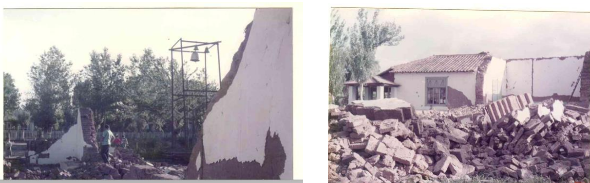
Imágenes del terremoto de 1985, Fuente: Biblioteca municipal San Rafael.
